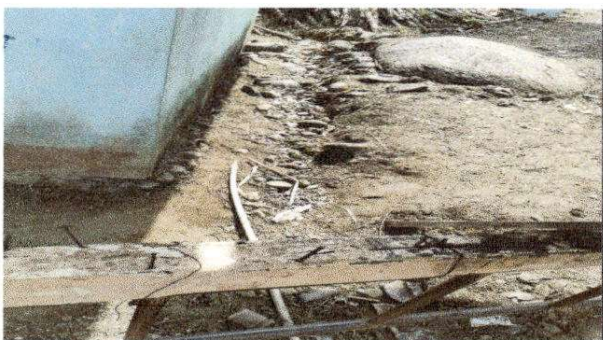
FOTO 11: Sustitución de tubería línea principal
