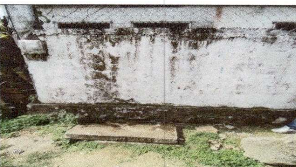
FOTO 10: Sustitución de caja de registro
