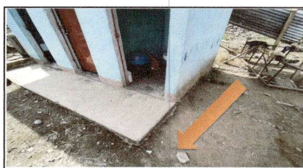
FOTO 6: Reparación de banquetas de concreto
