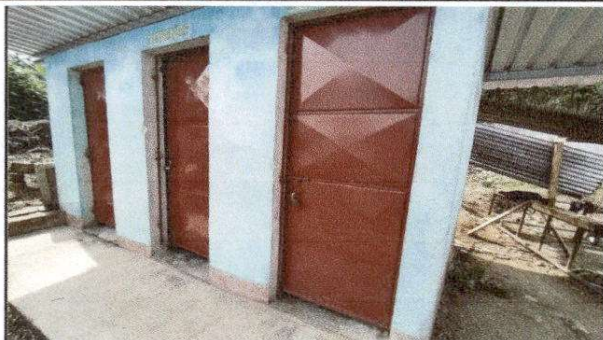
FOTO 7: Pintura en muros exteriores e interiores
