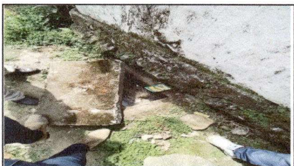
FOTO 9: Sustitución de caja de registro
